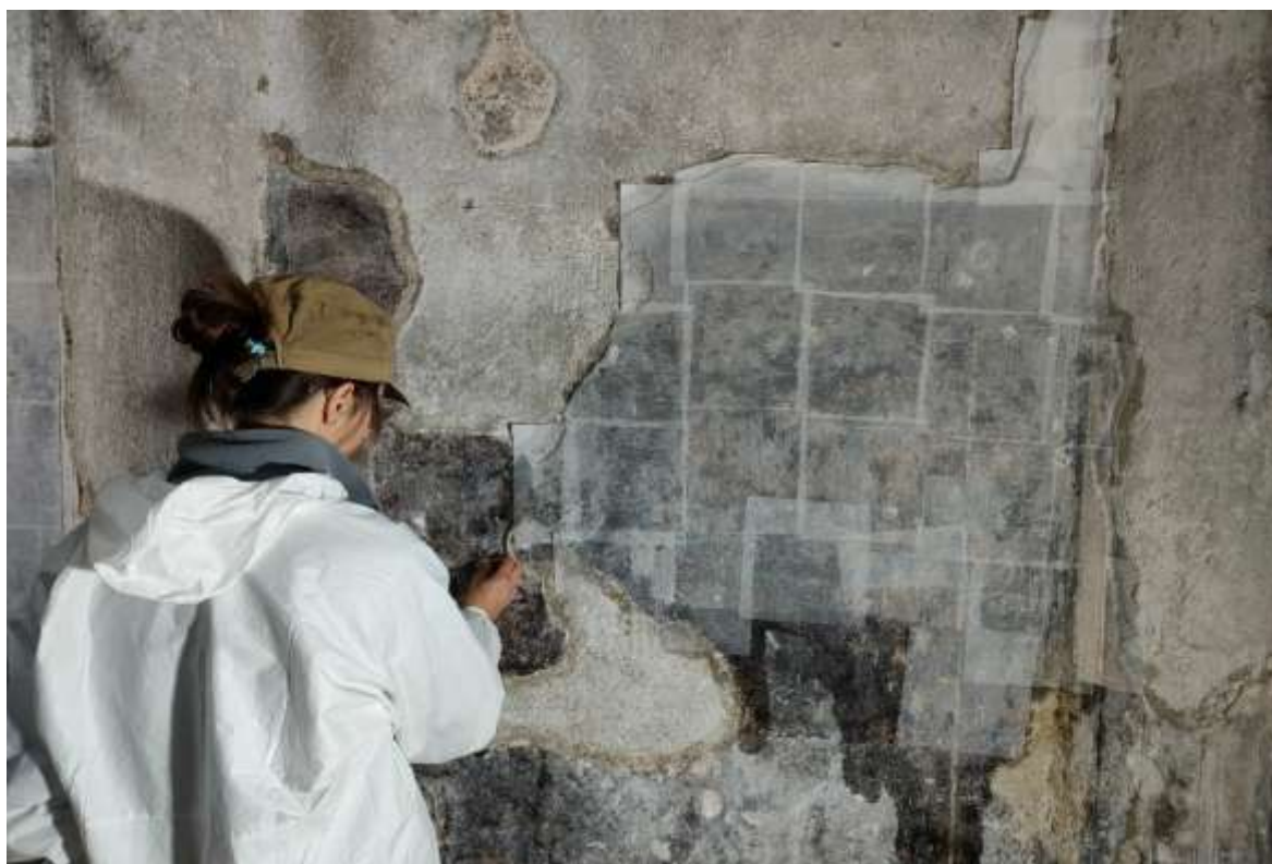
Lavori di pulitura della parete affrescata della sala del belvedere
